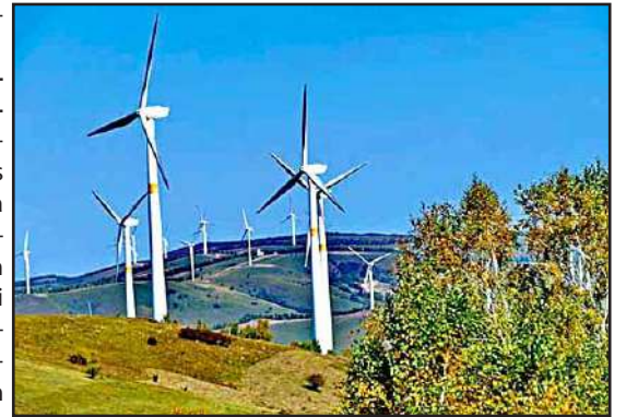
Kiina on jo saavuttanut ykkössijan aurinko- ja tuuliteknologian saralla. Maan arvioidaan investoineen vihreään teknologiaan enemmän kuin muu maailma yhteensä. Kiina on maailman johtava maa uusiutuvassa energiantuotannossa. Kuva China today
