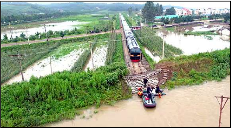
Tulvavahinkojen aluetta KDKT:n pohjoisosassa Amnok joella
