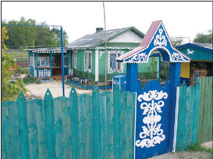
Valko-Venäjällä talous kasvaa ja myös perinteisten puutalojen paikalle rakennetaan uutta. Myös Ljaskovin kylässä rakennettiin uusia omakotitaloja. Toivottavasti paikalliset rakennusfirmat osaavat asiansa eikä toisteta niitä virheitä, joita vastaavissa tilanteissa syntyi meillä ja esim. Espanjassa. Hyvällä hoidolla tällä puutalolla on vielä 50 elinvuotta.
