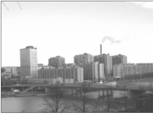
Rakennusliike Hakan yksi merkittävimmistä rakennuskohteista on ollut kuvassa oleva Merihaka lähellä Hakaniemen toria Helsingissä.
