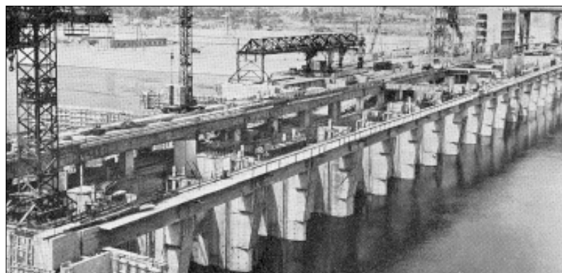
Goelro-suunnitelman toteuttaminen alkoi v. 1921 ja vallankumouksen 10-vuotispäivänä sähkön tuotanto ylitti 2,5 kertaisesti vallankumousta edeltäneen tason. 1-viisivuotiskauden jälkeen Goelro-suunnitelma oli runsaasti ylittynyt. Kuvassa Kiovan vesivoimalan patotyömaa Dnjeprillä.
